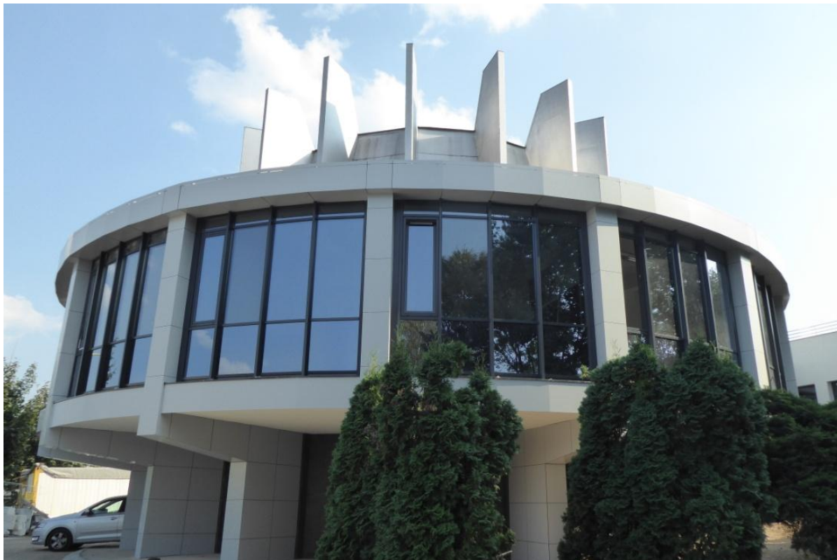
Budova planetária po rekonštrukcii – exteriér (rok 2019).
